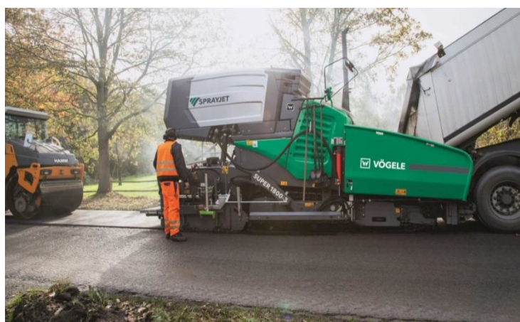
Рисунок 1 – Спеціальна техніка із розпилювачем мембрани для влаштування шарів зносу Figure 1 – Special equipment with a membrane sprayer for installing wear layers
