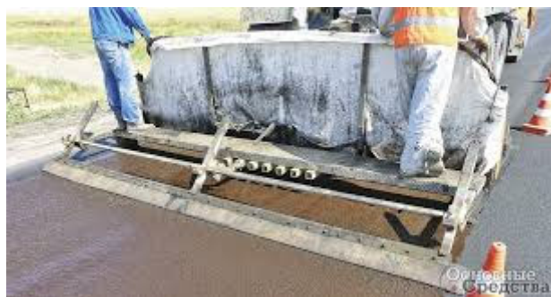
Рисунок 4 – Влаштування покриття ЛЕМС
