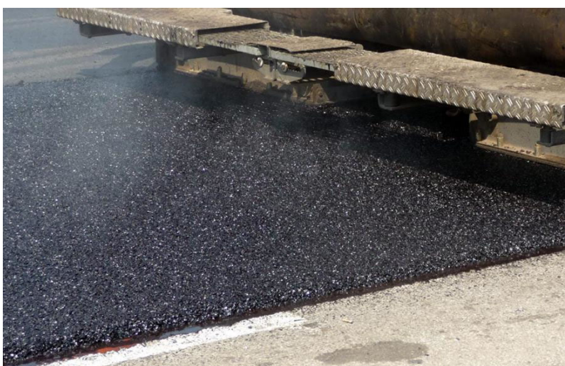
Рисунок 5 – Влаштування тонкого шару зносу із гарячої щєбенистої асфальтобетонної суміші.
