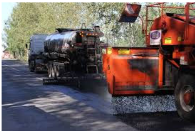
Рисунок 2 – Влаштування шорсткої поверхневої обробки із застосуванням емульсії та щебеню з роздільним розподілом матеріалів
